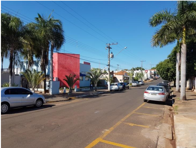
Foto 3.8 – Vista geral da área de alagamento
