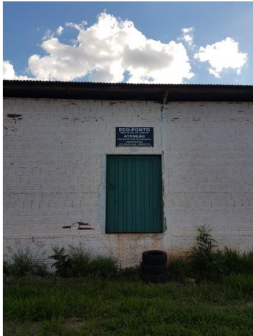
Foto 3.6 – Vista da área de armazenamento de pneus
