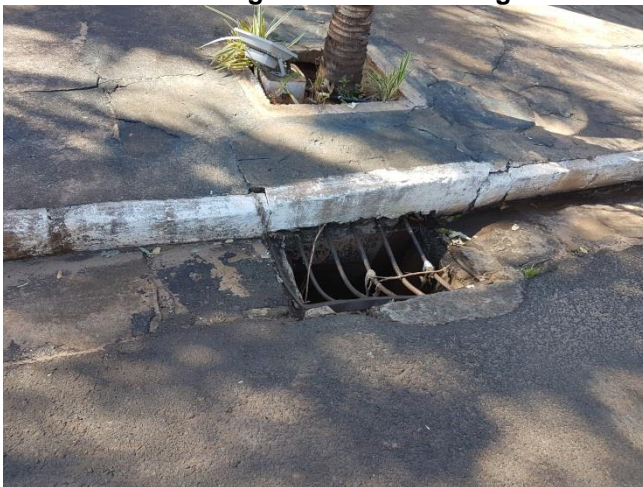
Foto 3.10 – Estrutura de microdrenagem
