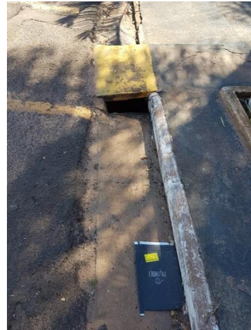
Foto 3.9 – Estrutura de microdrenagem
