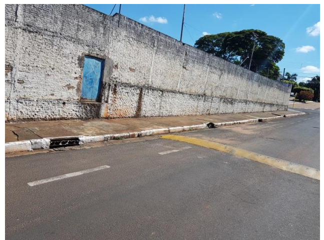
Foto 3.17 – Estrutura de microdrenagem
