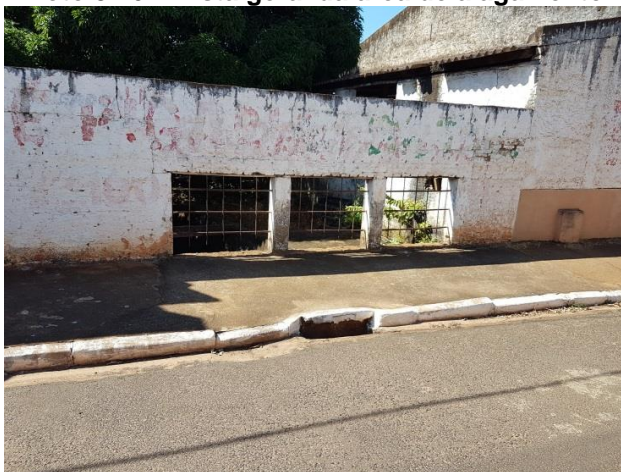
Foto 3.18 – Estrutura de microdrenagem
