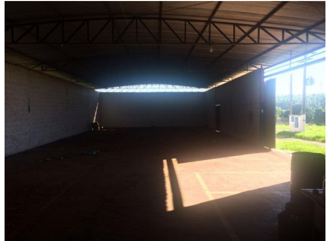
Foto 3.7 - Vista da área de armazenamento de pneus
